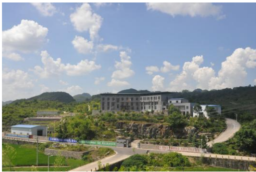
图 3 普定站主站址
