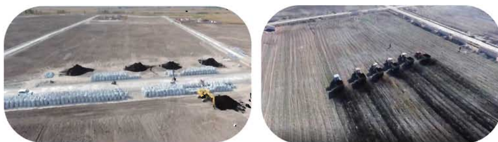
图1 改良材料机械化撒施作业
