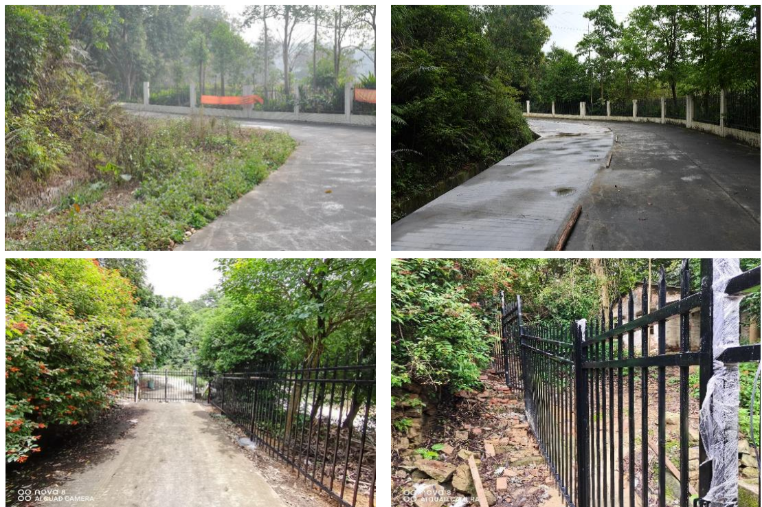
图9 鹤山站进站道路及围栏等基础设施改造
