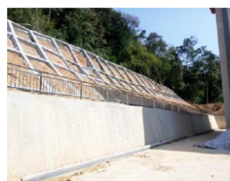
挡土墙修复后
