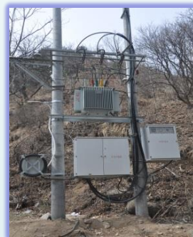
变压器电力更新改造项目
