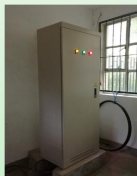
电缆和配电柜改造项目
