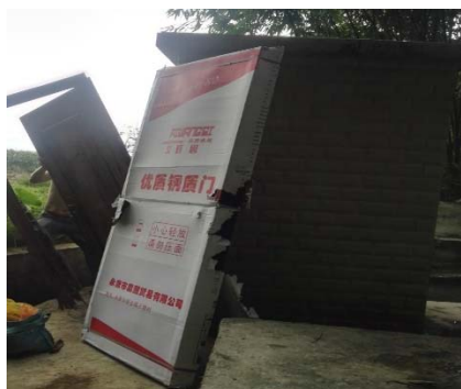
图 2.2 观测站点维修改造
