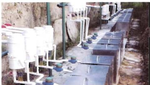
地表水、渗漏水收集装置
