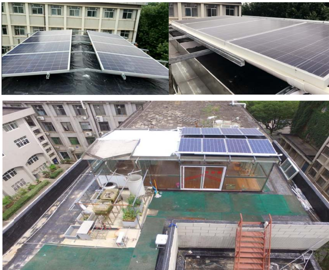
雨水收集-太阳能消毒一体化系统
