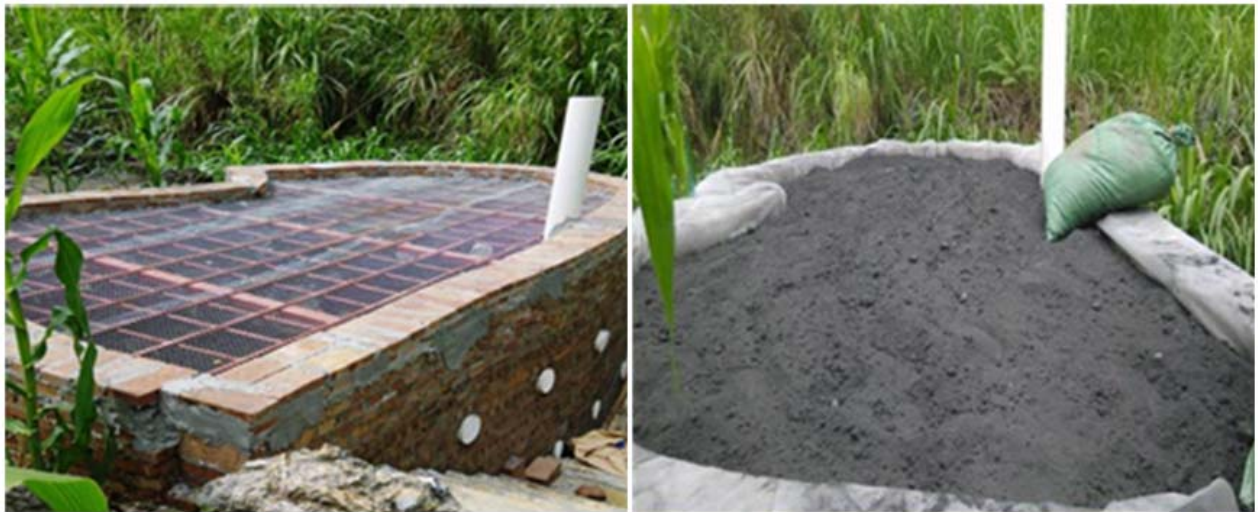
图 15 改良的峰丛洼地土壤与养分落水洞流失阻控设施
