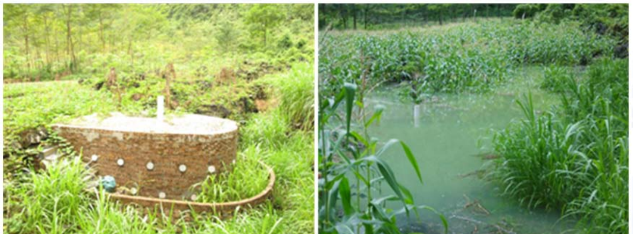
图 13 有效阻控峰丛洼地土壤与养分流失围墙设施
