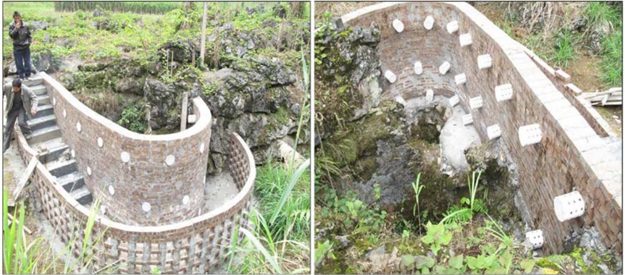
图 14 峰丛洼地土壤与养分落水洞流失阻控设施
