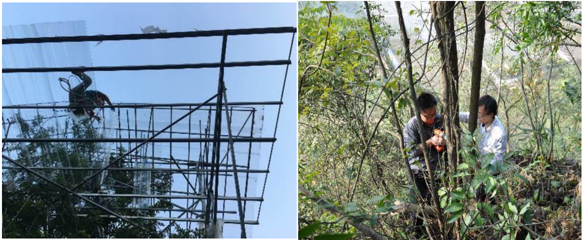
出露基岩遮雨设施修缮(左)与监测仪器安装(右)
